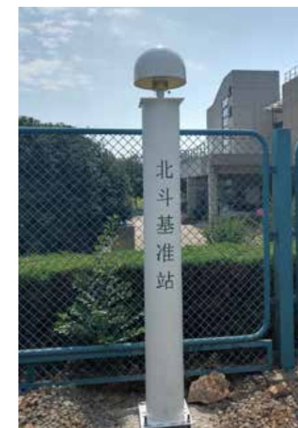
南京电力科学研究院电力北斗基站
