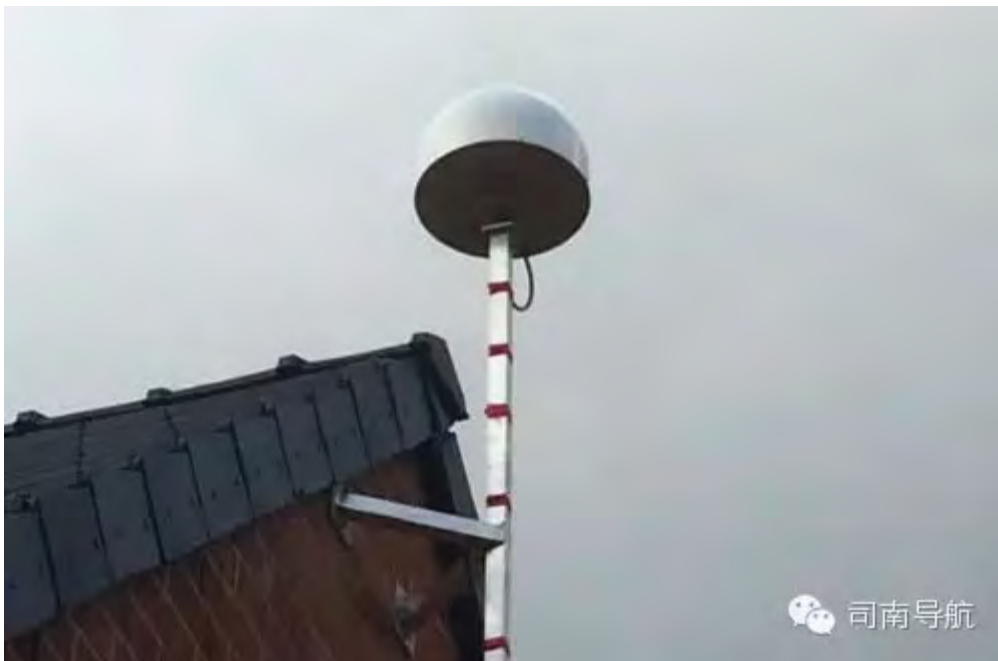
首个欧洲北斗固定跟踪站建立
