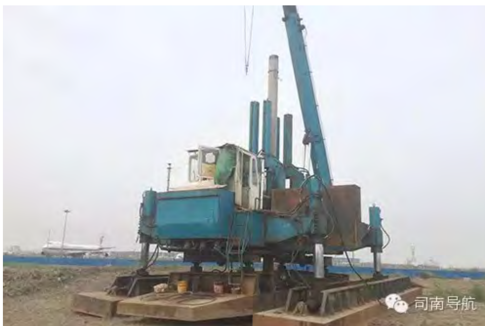
安装了高精度智能导航控制系统的压桩机现场使用
